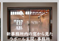
交流スペース奥に新設
